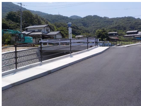
総頭川1号線（寺参橋）
