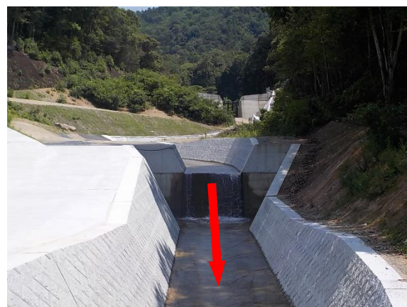
天地川支川2（小屋浦4丁目：広島県施工）
